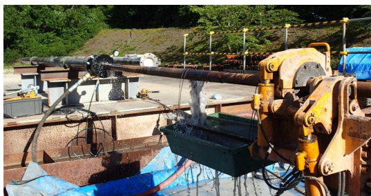
写真1 試験の全体状況
