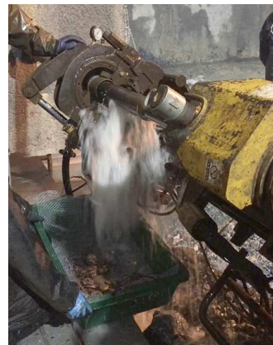
写真4 リバース水とコアの採取状況
