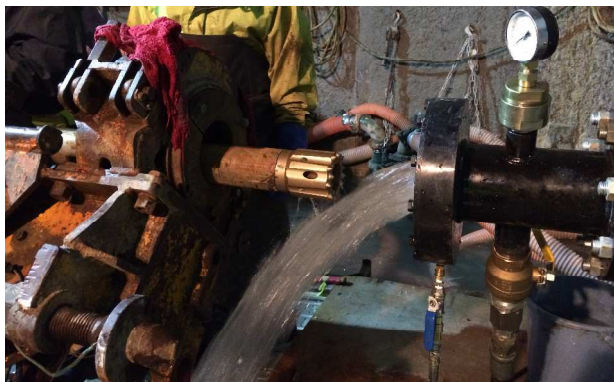
写真3 削孔前のコアビットと湧水の状況
