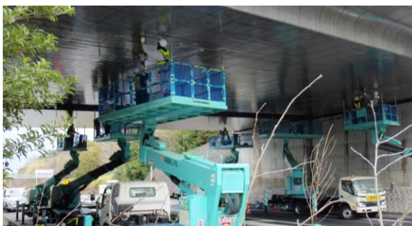
写真1 タフメッシュ工法の施工状況
