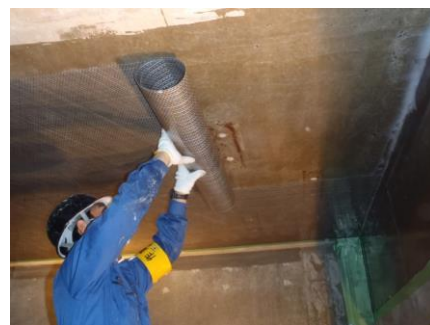
写真1 タフメッシュ工法の施工状況
