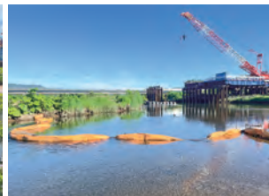
オイルフェンスの設置
