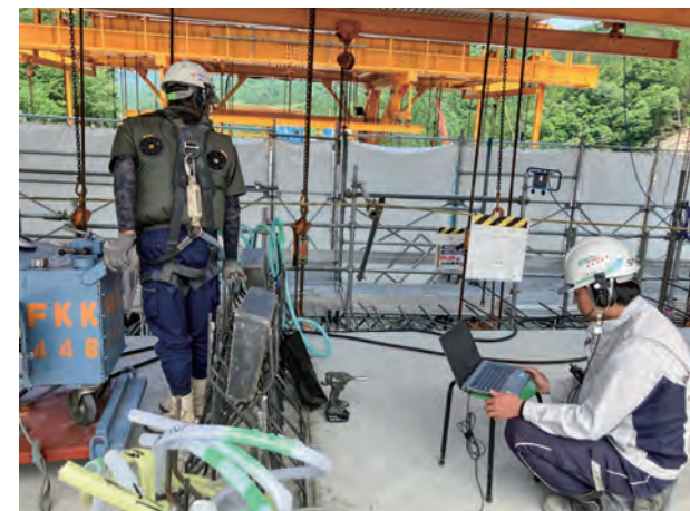
騒音対策(緊張作業時無線利用)
