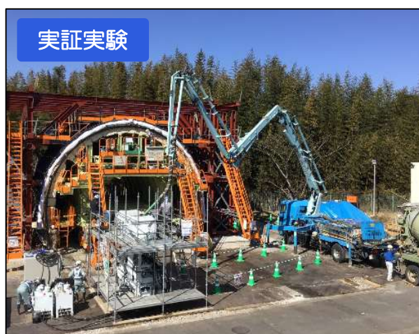
模擬トンネル打設試験
