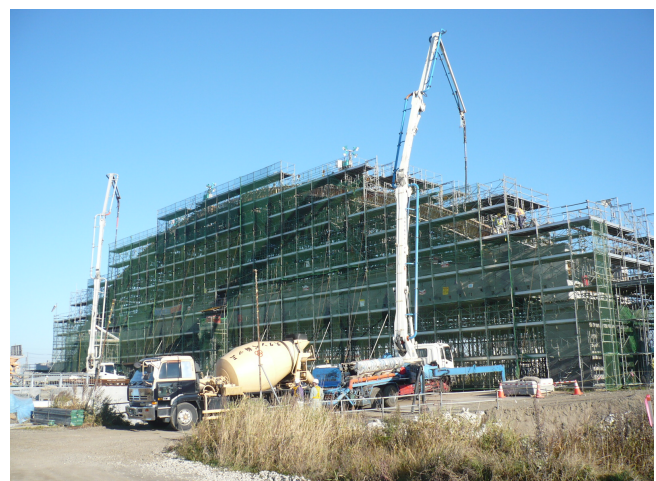
写真-4 1ロット目打設状況
