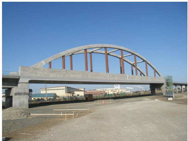
写真-6 完成状況
