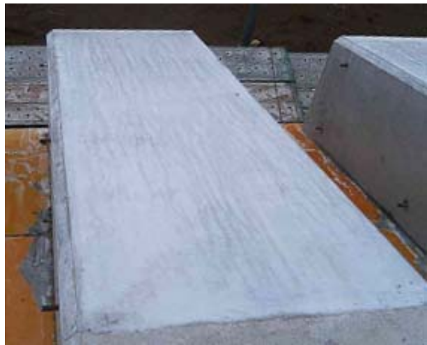
写真-3 均し仕上げ後の天端状況の一例
