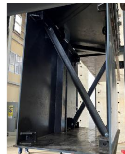
写真-8 組立完了
