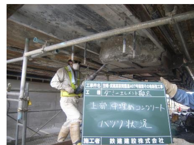
写真-2 間詰めモルタルの研り作業
