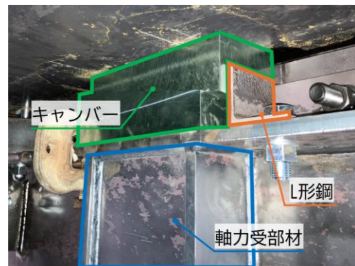
写真-3 キャンバーの設置状況
