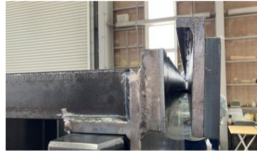
写真-5 ボルトを緩めた継手
