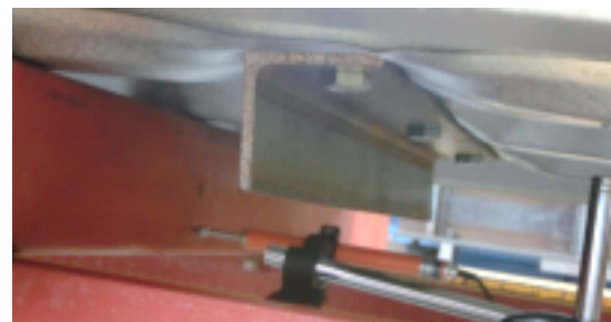
【屋根裏面状況（折板直交方向）】
