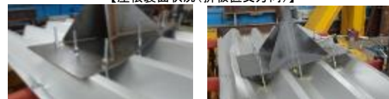
（試験体1） （試験体2） 【屋根上面状況（折板直交方向）】
