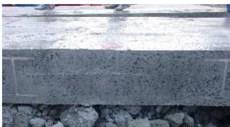
写真-6 支保工まわりコンクリート充填状況
