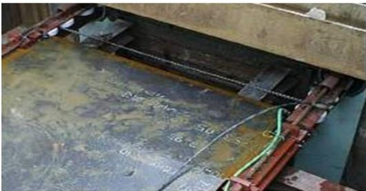
写真-2 地盤切削・鋼板挿入試験状況 (発進立坑)
