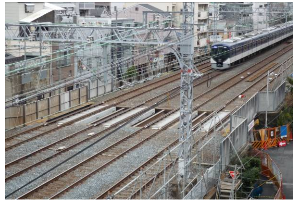
写真-1 複並第3架道橋（施工完了後）
