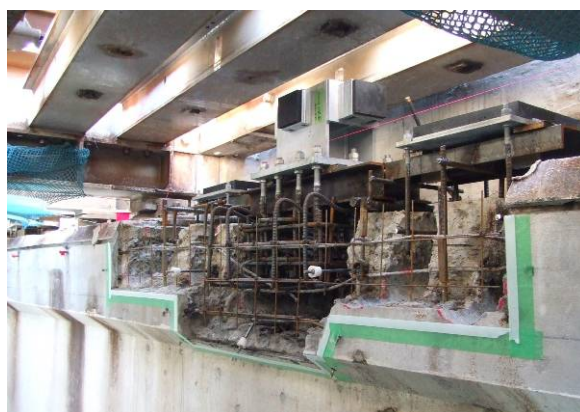
写真-3 支承部の施工状況
