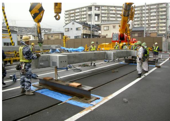
写真-2 軌道桁の架設試験状況
