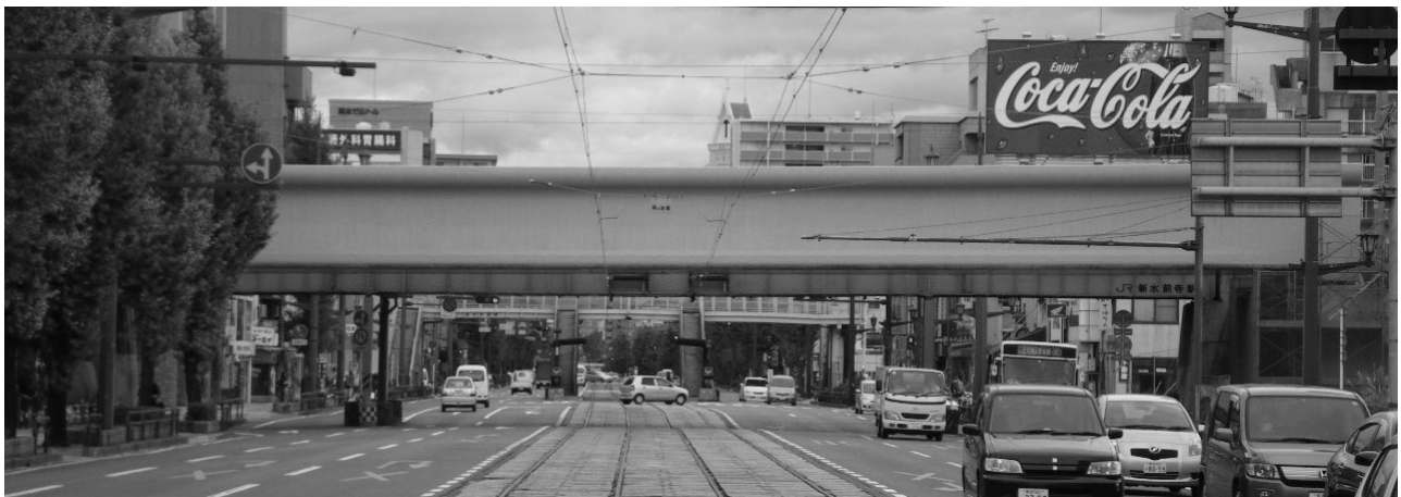
写真-5 施工完了
