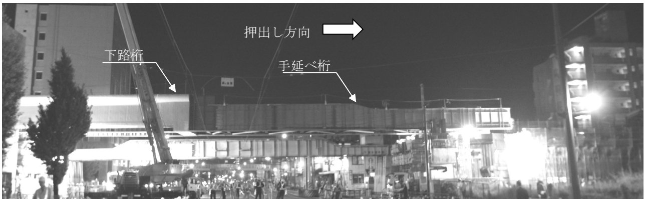
写真-4 押出し架設状況
