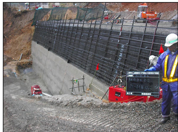
写真-7 壁面工施工状況
