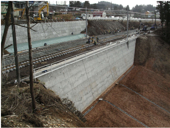
写真－10 復旧完了全景
