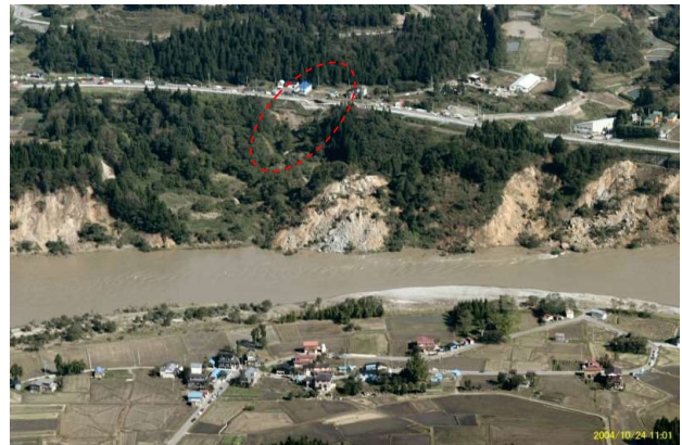
写真-1 崩壊箇所遠景
