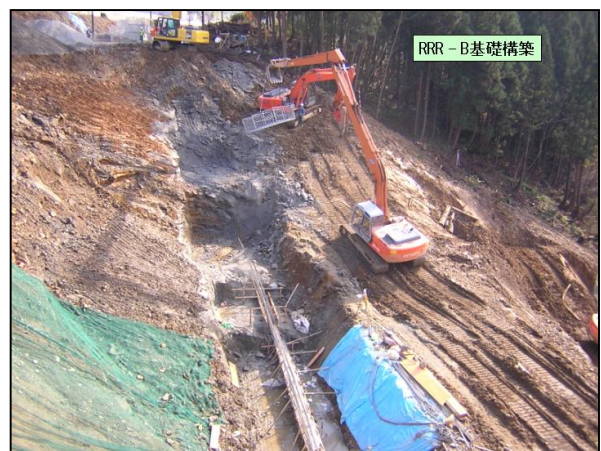
写真-6 基礎施工状況
