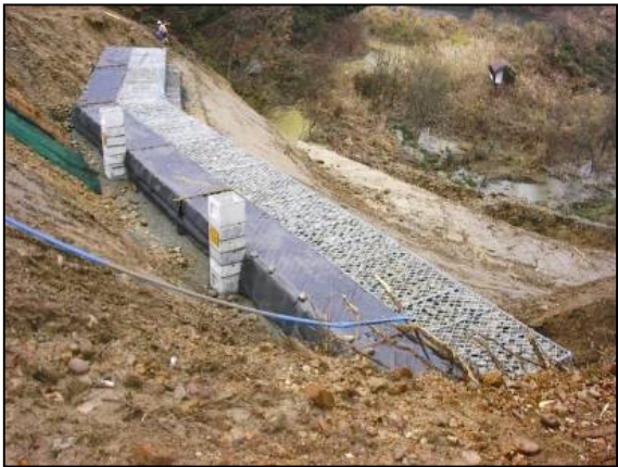
写真－8 ふとんかご設置状況
