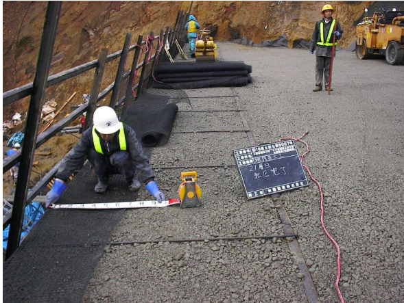
写真-5 補強盛土材盛りたて状況
