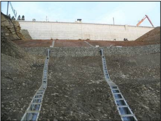
写真－9 のり面排水状況
