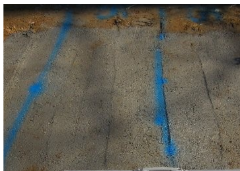
写真-3 転圧後の表面状況
