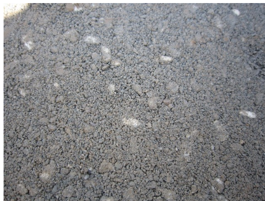
写真-7 転圧後の表面状況
