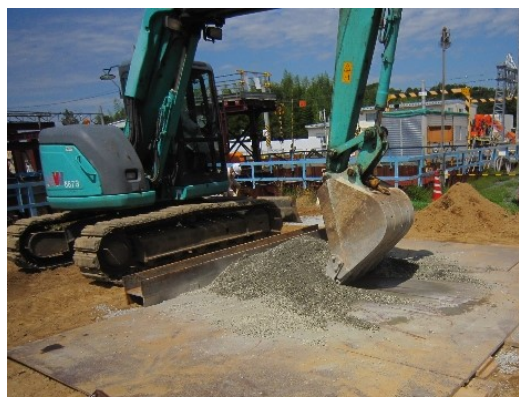
写真-5 路盤材の混合状況
