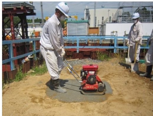
写真-6 転圧状況
