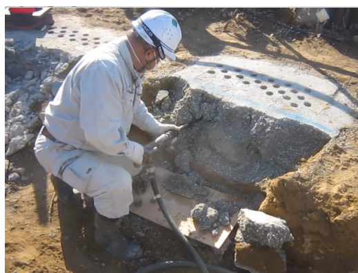
写真-8 はつりの作業状況
