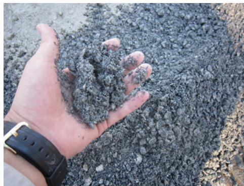
写真-2 路盤材の混合後の状況
