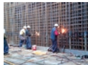
鉄筋圧接状況
