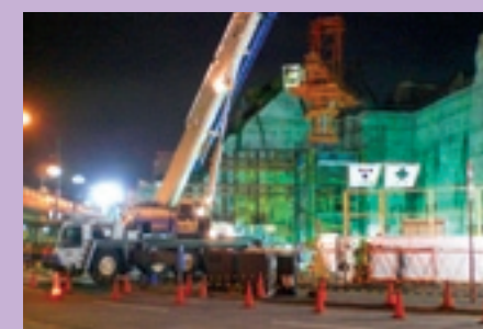
夜間鉄骨建方施工状況
