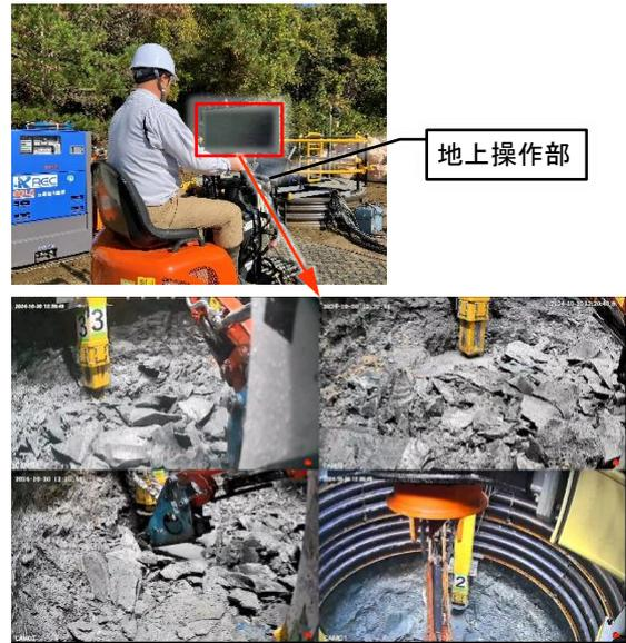
写真-5 オペレーター掘削状況確認モニター
