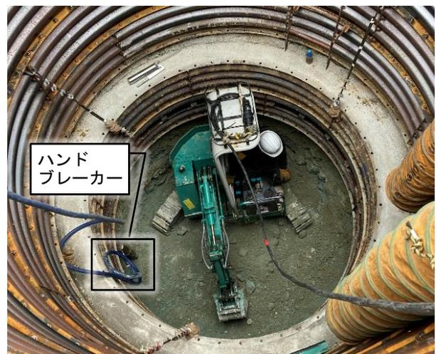
写真-1 従来工法による深礎掘削作業
