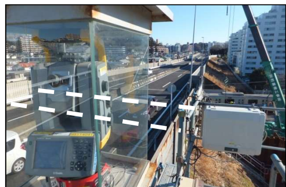
写真-2 地表面変位計測状況
