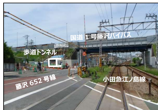
写真-1 施工箇所全景
