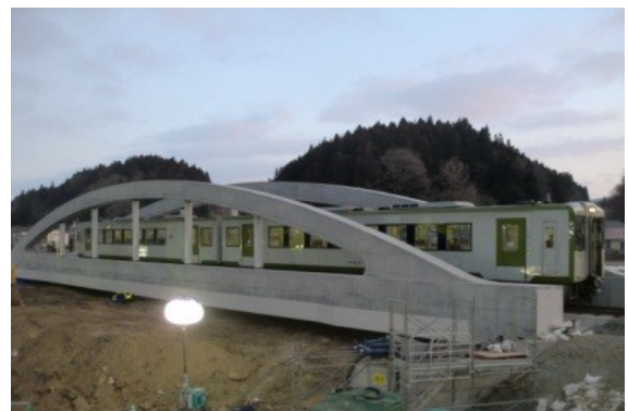
写真-7 横取り架設完了
