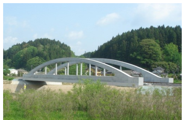
写真-8 夏井川橋りょう完成
