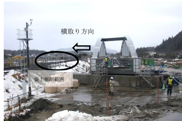
写真-5 横取り架設前全景
