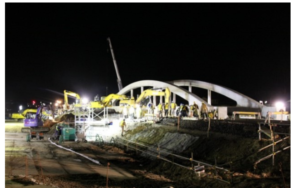
写真-6 盛土掘削状況
