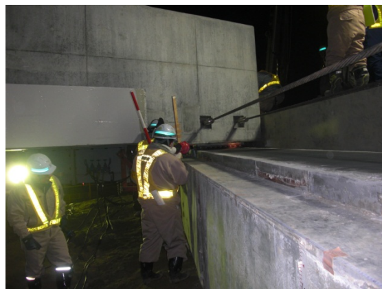
写真－3 牽引中計測状況
