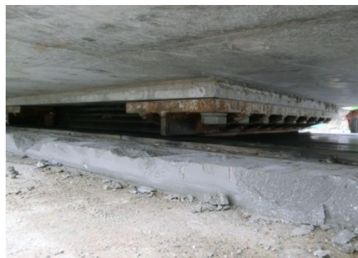
写真-2 すべり支承構造
