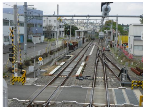
建設技術総合センター（屋外研修フィールド）
