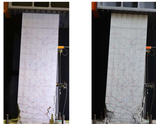
4 δ y の1回目 5 δ y の2回目 写真-2 試験体 No. 1 の損傷状況
