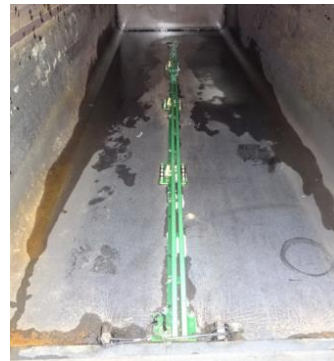
写真-1 角形鋼管柱内帯状濡れセンサ設置状況
