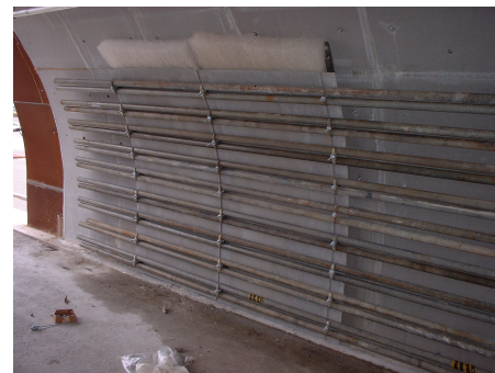
写真-4 固定材取付
