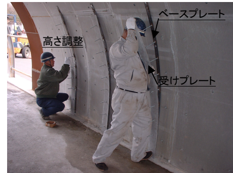
写真-2 受けプレート取付
