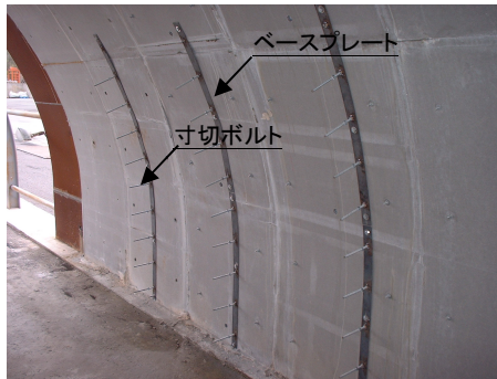
写真-1 ナット付きベースプレート取付
