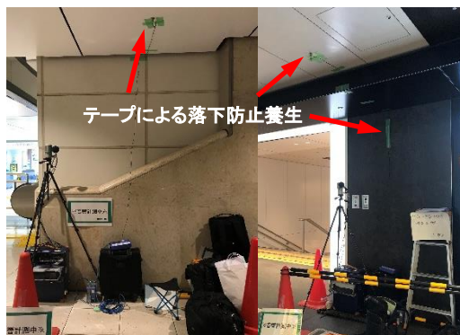
写真-2 測定点の設置状況
