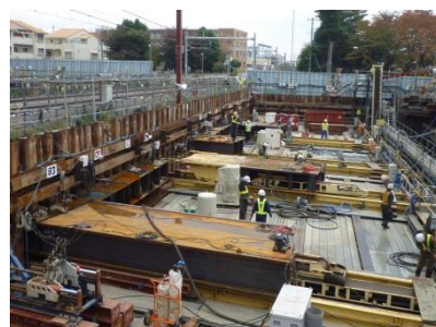
地盤切削JES工法 施工概要
