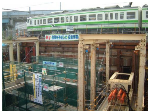
HEP工法 施工状況
