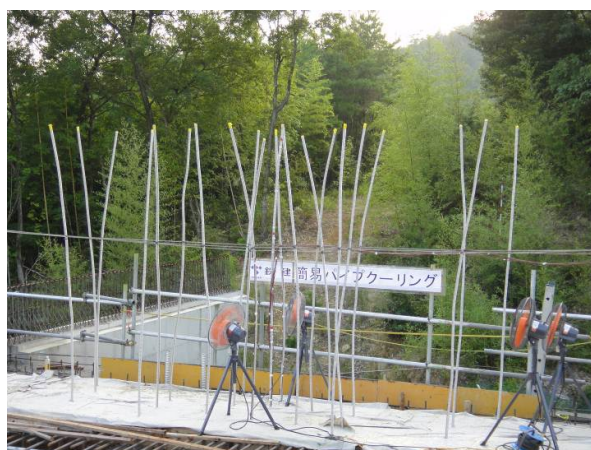
写真-2 ヒートパイプを利用したパイプクーリング状況
