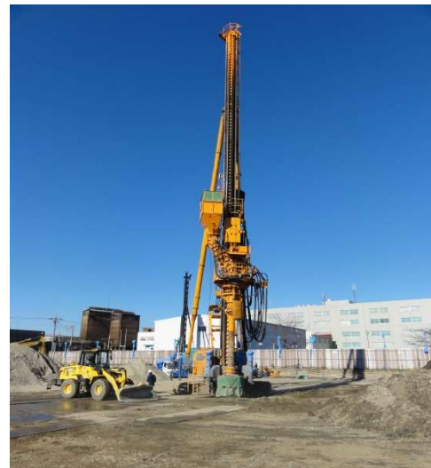
写真-1 HCP工法の施工状況
