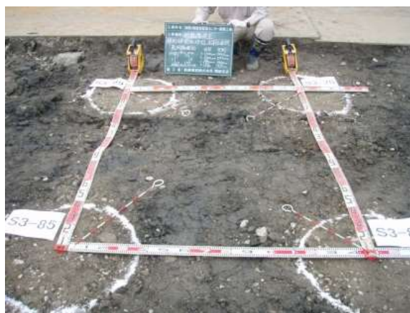
写真-2 砂杭の杭間隔
