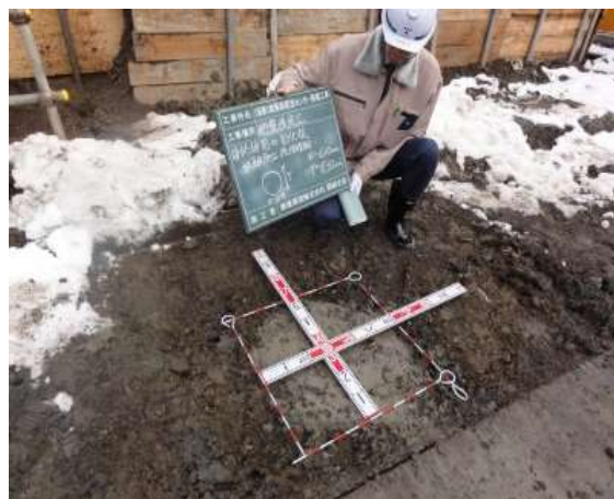
写真-3 固化杭の出来形(杭径)
