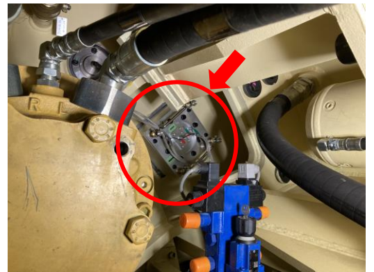
上部ソナー取付け状況
