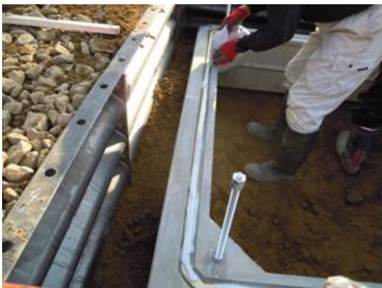
写真-5 パッキンおよび接着剤塗布
