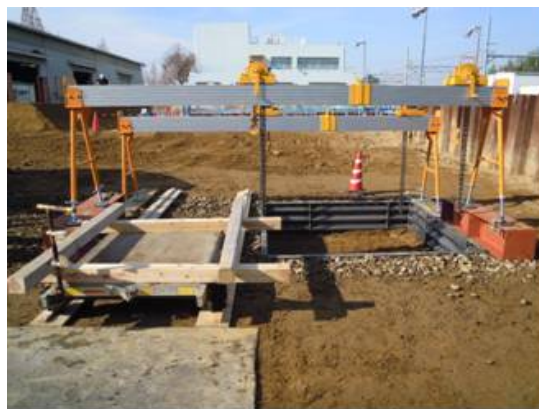
写真-1 矩形ライナーおよび吊り下げ装置
