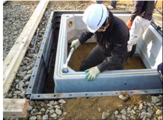
写真-7 トルクレンチによる増締め
