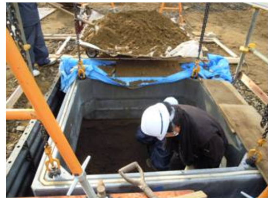
写真-8 掘削・沈設
