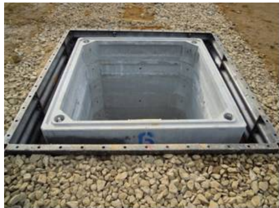
写真-14 ハンドホールセット完了
