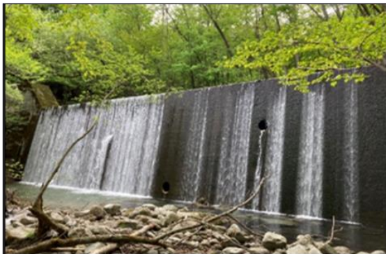
▲取水地点の堰堤（現在）
