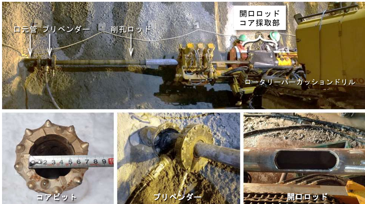
写真-1 PS-SR 工法主要機器および坑内設置状況
