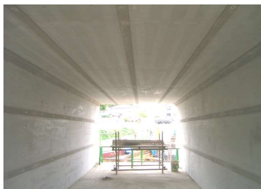
図-17 函体内部全景
