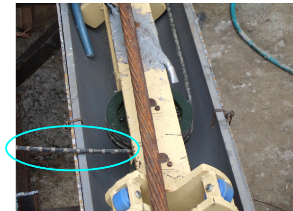
図-9 改良後地盤切削ワイヤー
