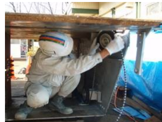
写真-7 刃口内からのワイヤー交換状況
