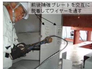
写真-8 中壁部のワイヤー通過作業状況
