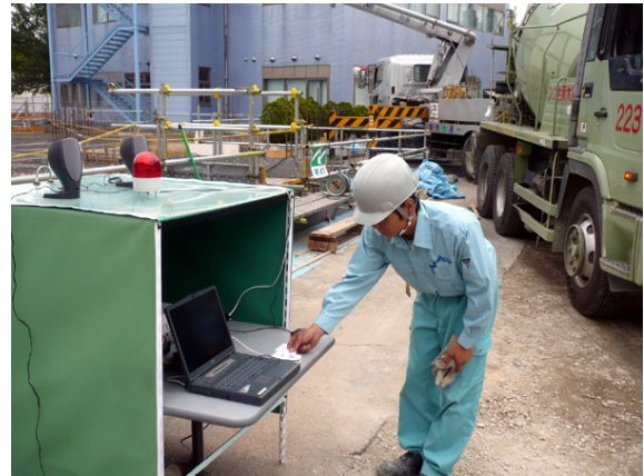
写真-3 打設現場での IC カードから パソコンへのデータの書込み状況
