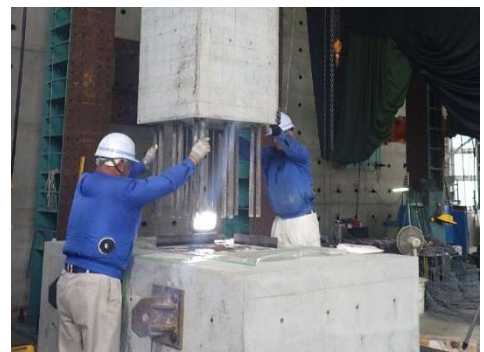
写真-2 柱建込み状況
