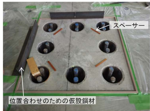
写真-1 フーチング上面の柱設置箇所
