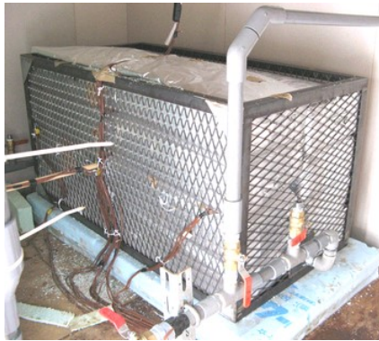
写真-1 潜熱蓄熱体
