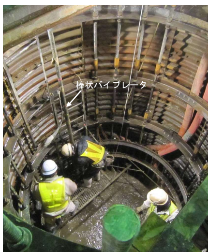
写真-9 実施工例
