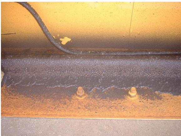
写真-4 下向きの吹付け被膜
