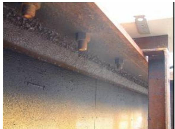
写真-6 上向きの吹付け被膜
