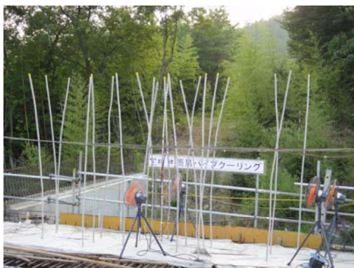
ヒートパイプによるクーリング状況 （東広島・呉道路 馬木高架橋PC 上部工事）
