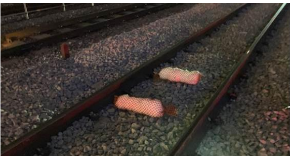
(b)土のう撤去時（相対的な陥没状態） 写真－2 土のうによる変状の再現
