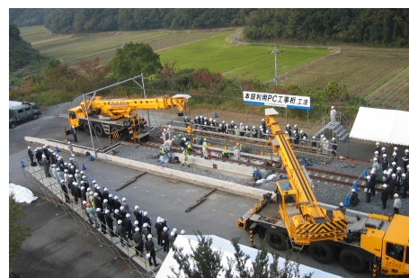
写真－2 施工状況
