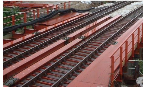
写真-1 従来工事桁(抱き枕木式)
