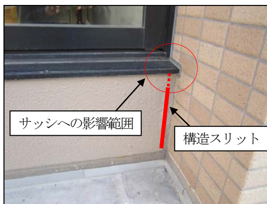
図-1 スリット施工部分
