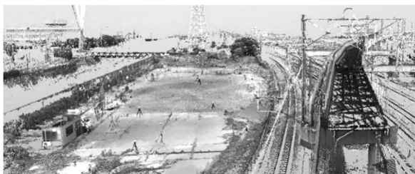
図-5 P8 橋脚側点群
