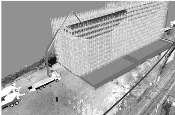
図-8 P8 橋脚コンクリート打設状況
