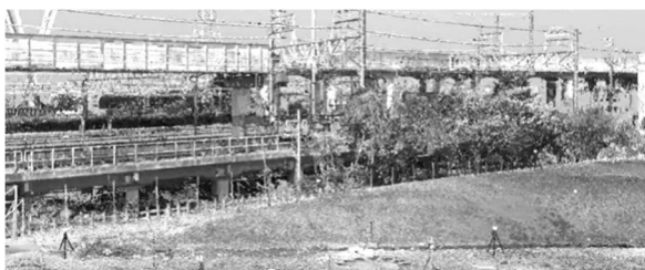
図-4 P7 橋脚側点群
