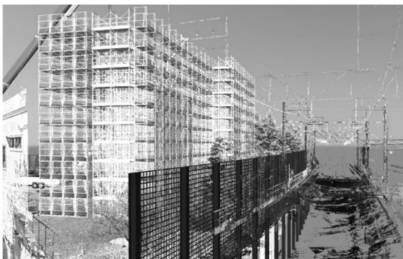
図-10 列車運転士からの P7 橋脚施工状況
