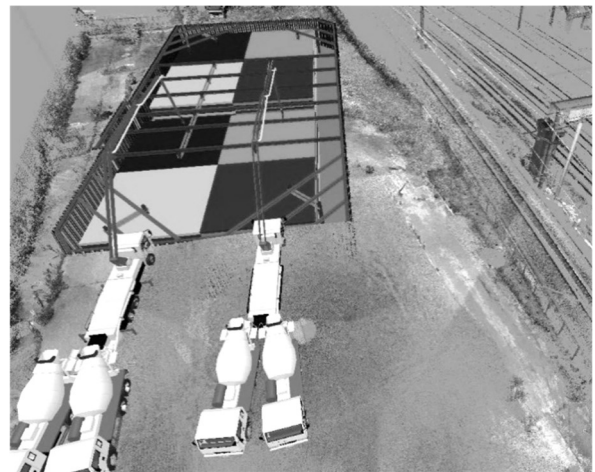
図-7 P8 橋脚フーチングコンクリート打設
