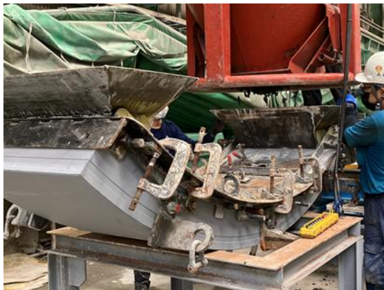
写真-6 GPC 打設状況
