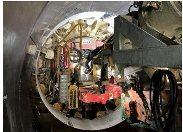
写真-10 GPC セグメント現地設置状況
