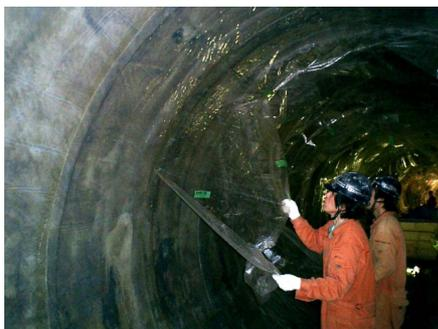
写真-7 保護フィルム剥がし状況
