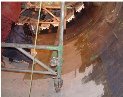
写真-4 タフシート貼付け状況 (下部)
