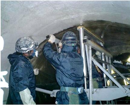
写真-3 タフシート貼付け状況 (上部)
