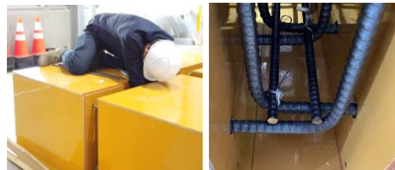
(a) 基礎厚 550mm (b) 結束状況
