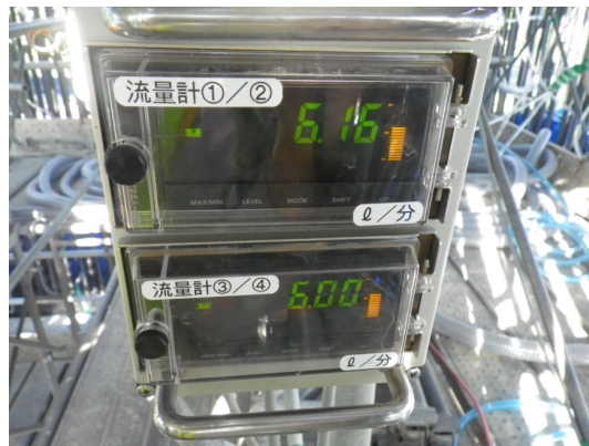
写真-5 流量デジタル表示
