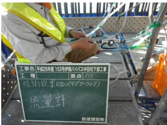
写真-4 流量計設置状況
