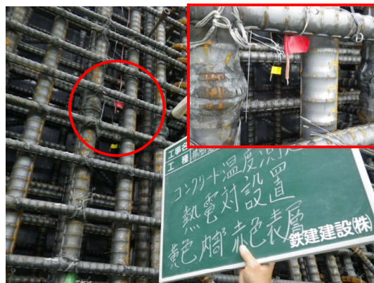
写真-6 熱伝対設置状況
