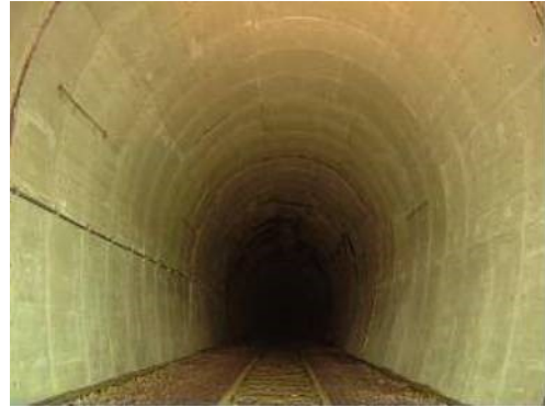
写真-6 施工完了
