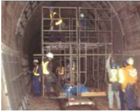
写真-5 移動足場
