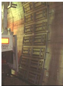
写真-1 押し枠取付け状況
