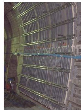
写真-2 単管パイプによる固定状況
