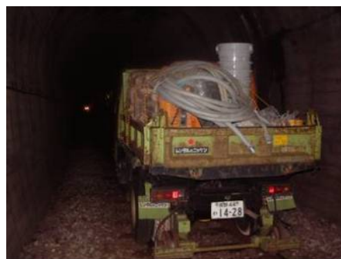
写真－３ 資機材運搬
