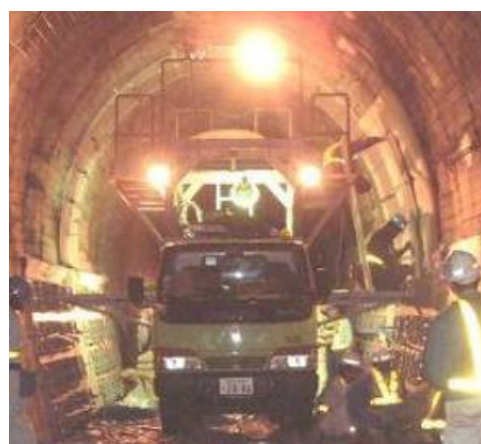
写真－４ 移動足場
