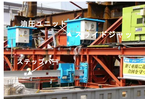
写真－３ スライド設置状況
