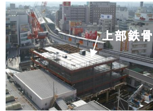
【2回目完了～後続鉄骨建方】
