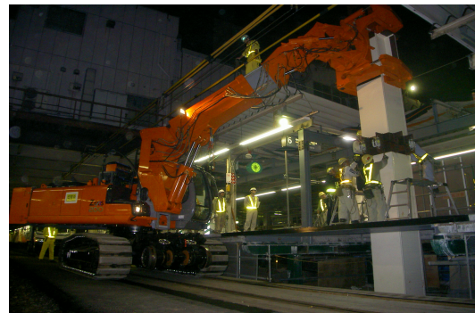
写真-1 HD マシンによる建込状況
