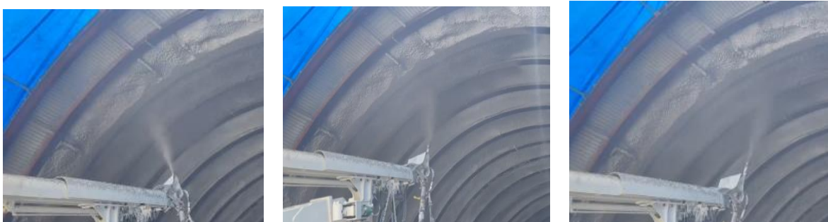
写真-7 脈動連動添加あり吹付け状況
