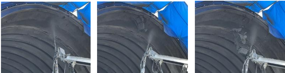
写真-6 脈動連動添加なし吹付け状況
