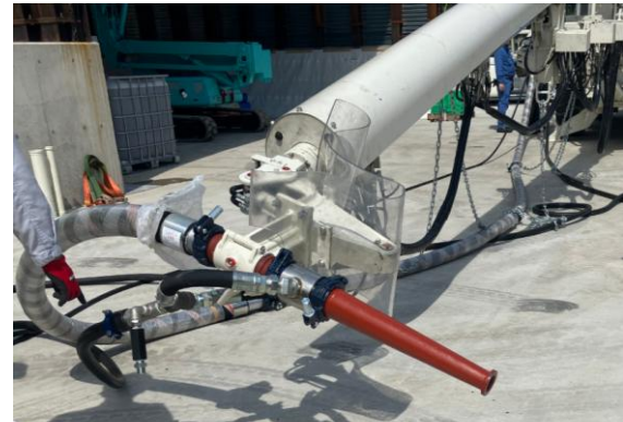
写真－4 吹付ノズル
