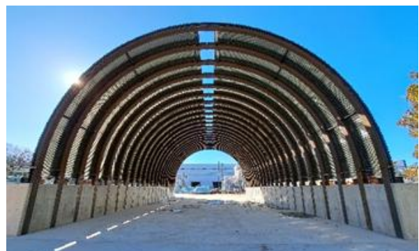
写真－2 模擬トンネル内部
