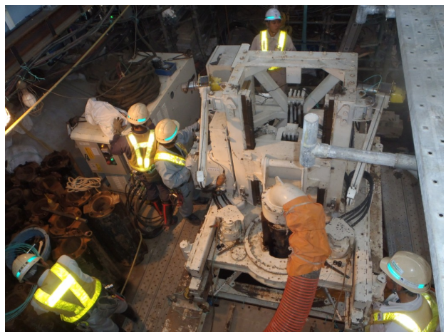
写真-3 コンパクトリバースJET18の施工状況
