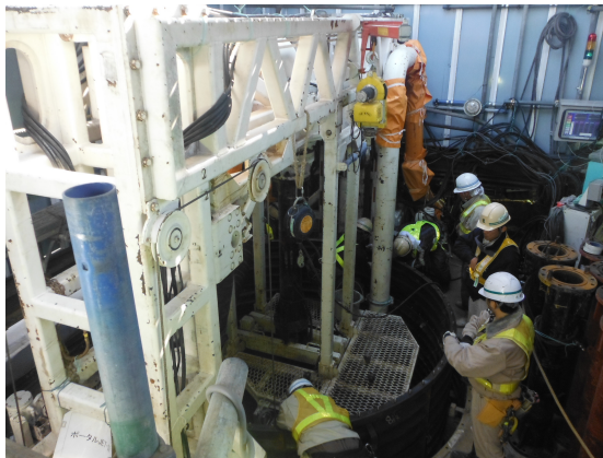
写真-1 ポータルJET32の施工状況
