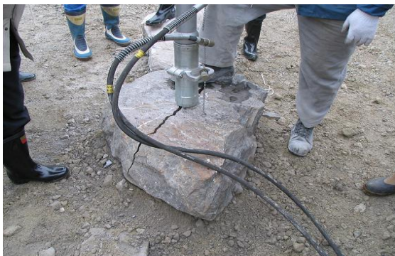
写真-7 割岩状況
