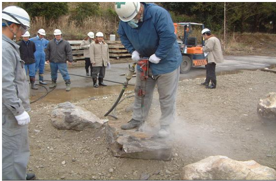
写真-6 削孔状況
