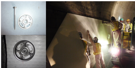
写真-4 アンカー形状とシート貼付状況
