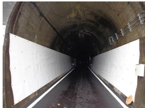
写真-5 内装シート敷設状況
